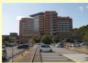
災害拠点病院建設前地盤改良
