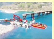
四方十川岩崩落下復旧旧工事
